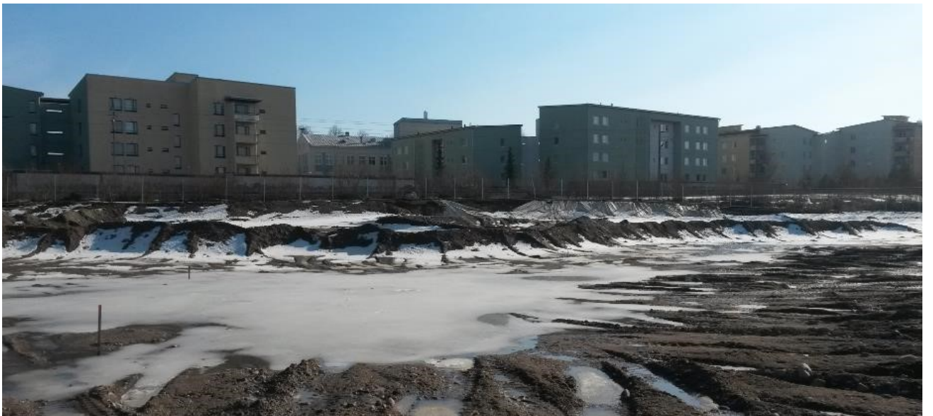
Kuva 10. Valokuvia suunnittelualueelta (2016): Abloyn entinen tontti ja radan eteläpuolella näkyvä kerrostaloalue
